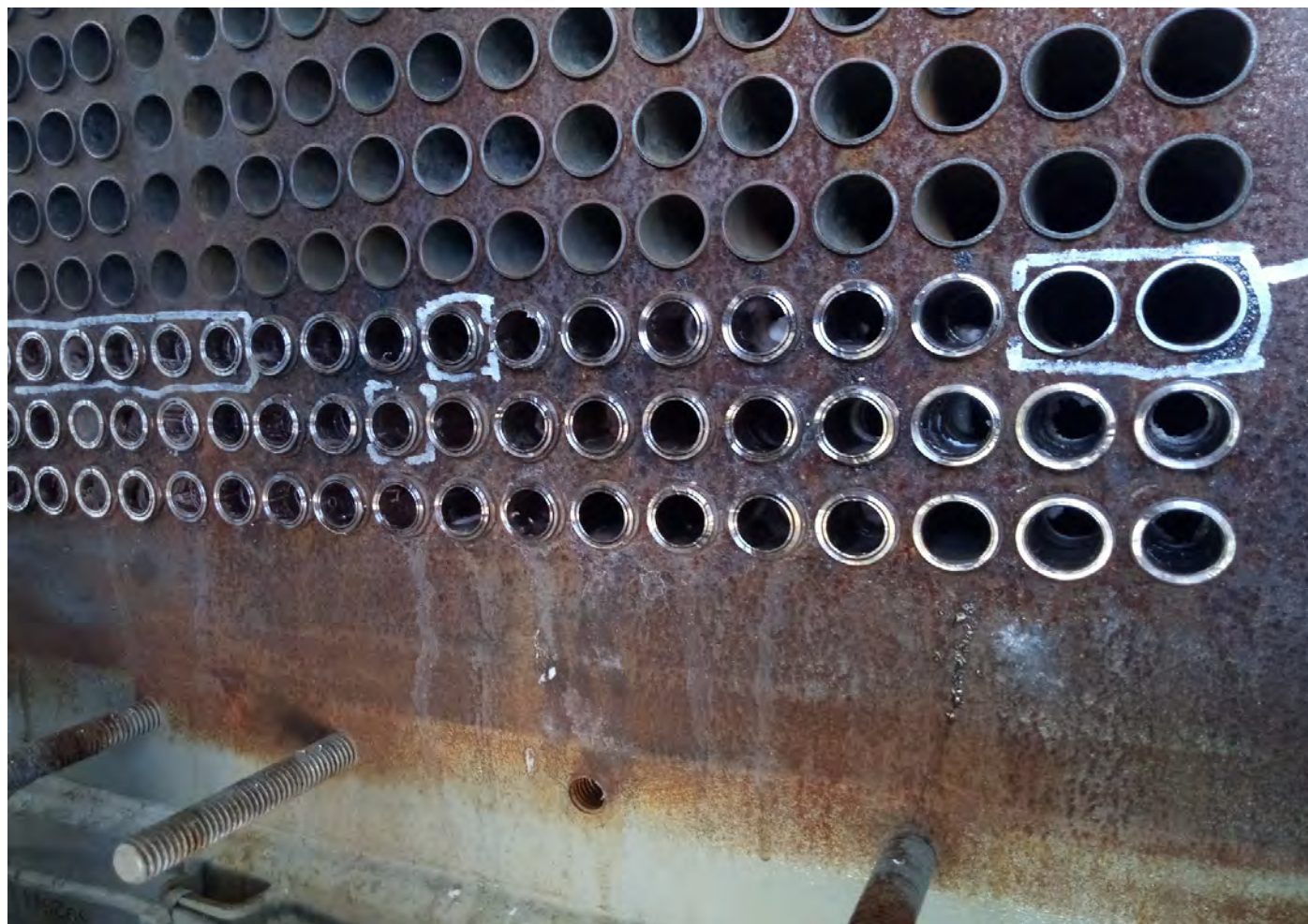
Торцевание выступающих концов трубных вставок
