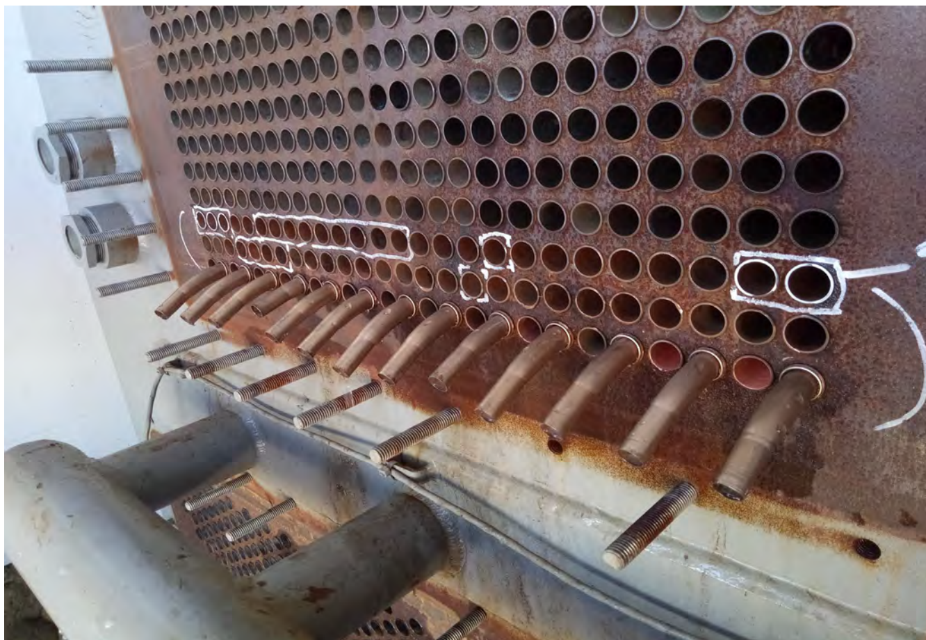
Трубные вставки на всю длину после гидравлического расширения
