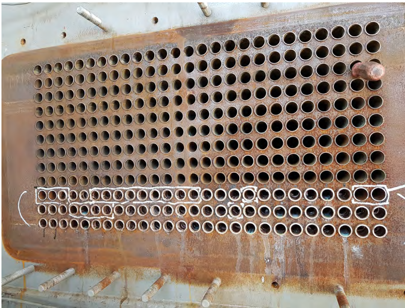
Трубный пучок испарителя после выполнения работ
