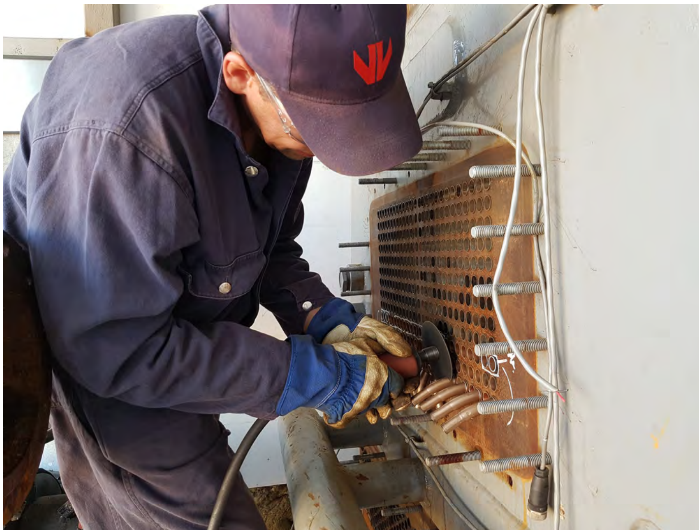
Подрезание выступающих концов трубных вставок на всю длину
