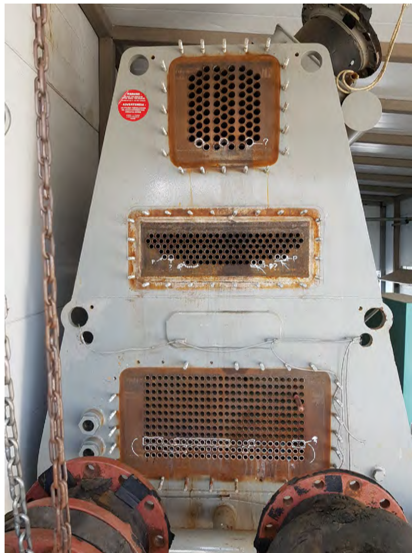
Холодильная машина после выполнения работ по установке вставок на всю длину
