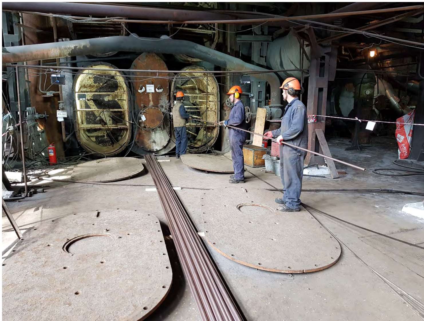
5. Процесс установки вставок на всю длину (Лайнеров) в ранее заглушенные трубки
