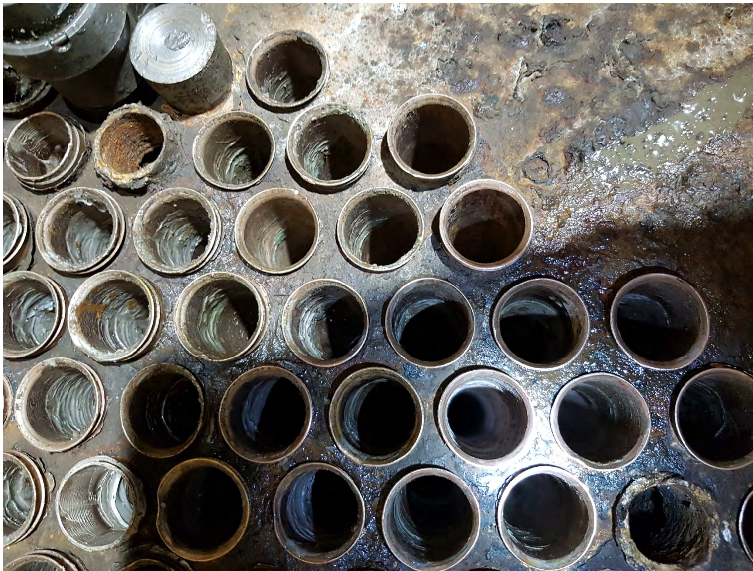
8. Входные участки теплообменных трубок после выполнения работ
