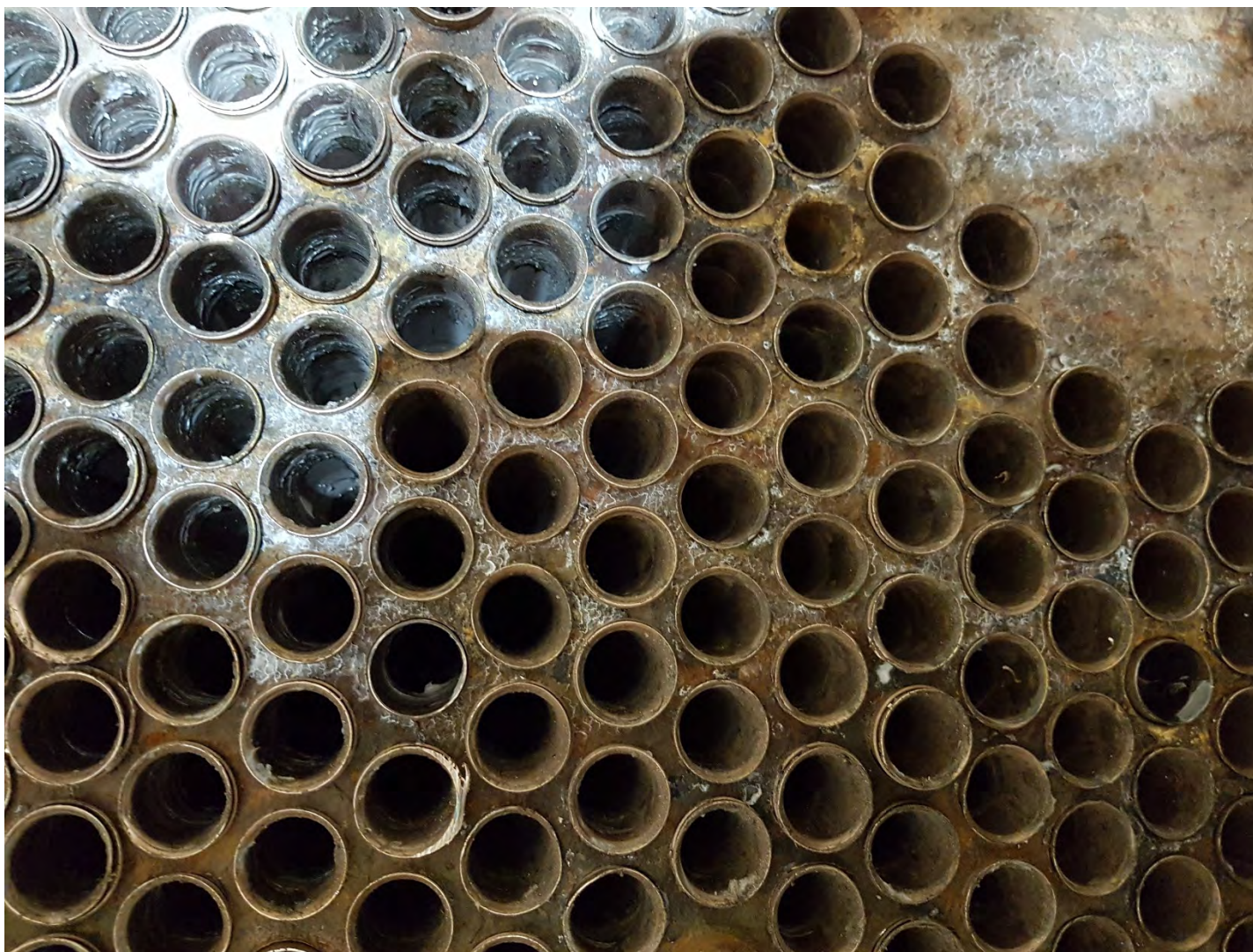
7. Входные участки теплообменных трубок после выполнения работ
