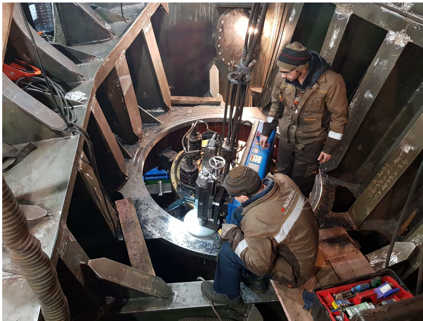
Обработка верхней поверхности фундамента
