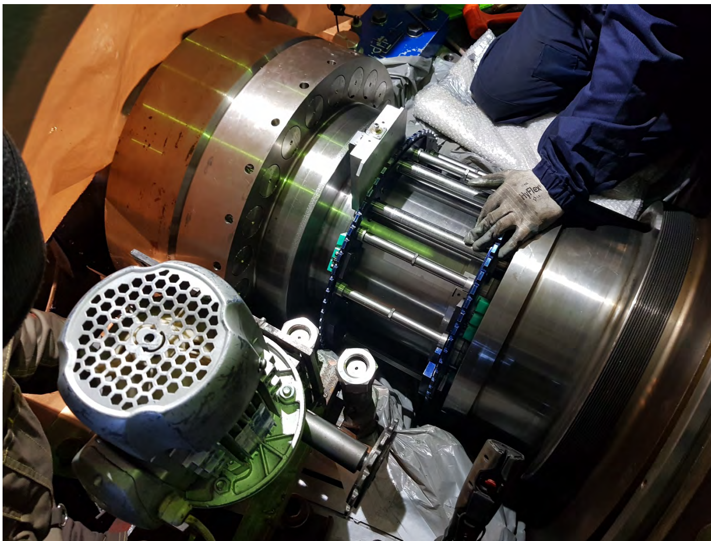
Установка мобильного переносного станка на ротор газовой турбины
