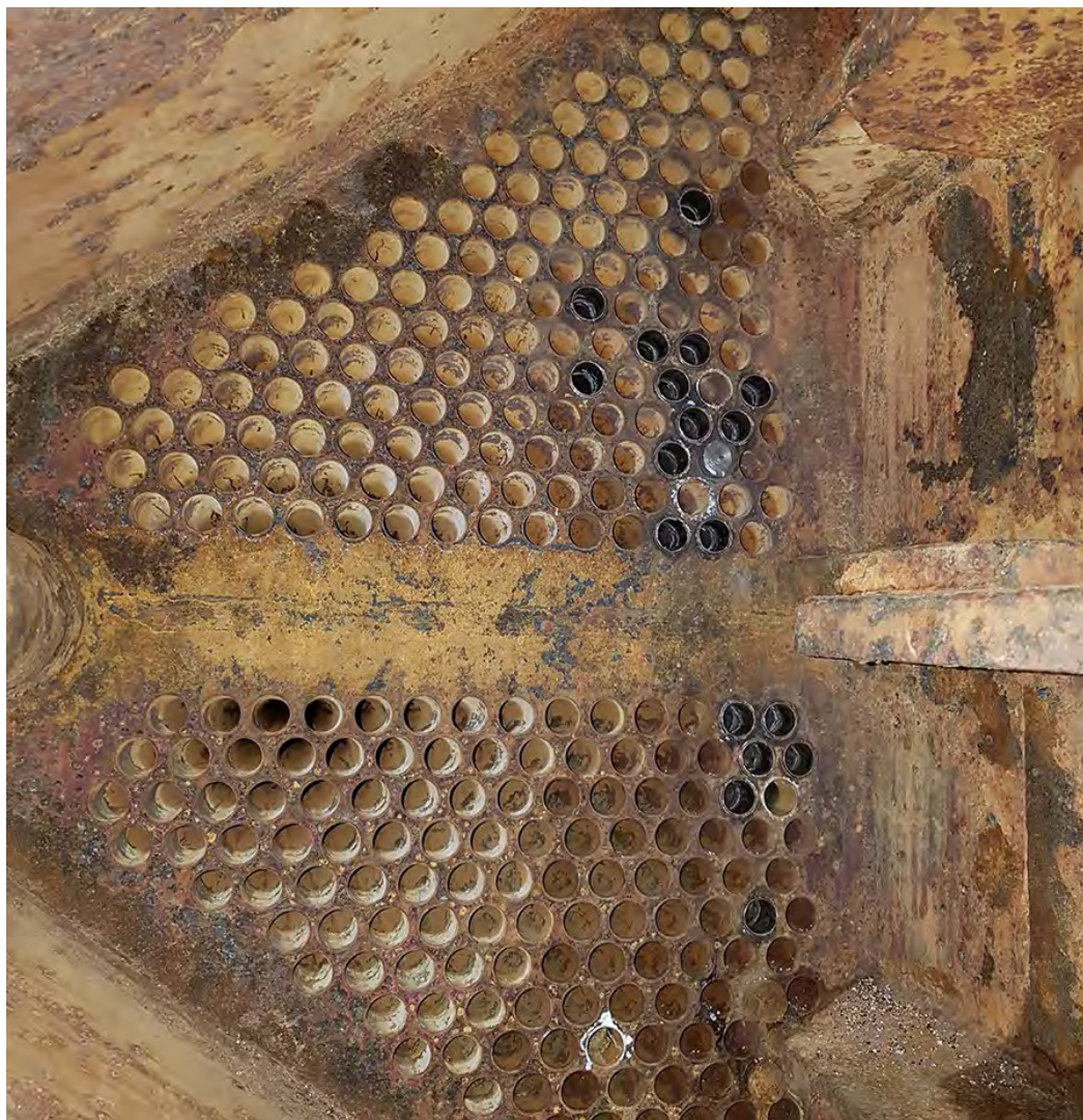
6. Трубная доска после выполнения работ на одном ходу первой секции
