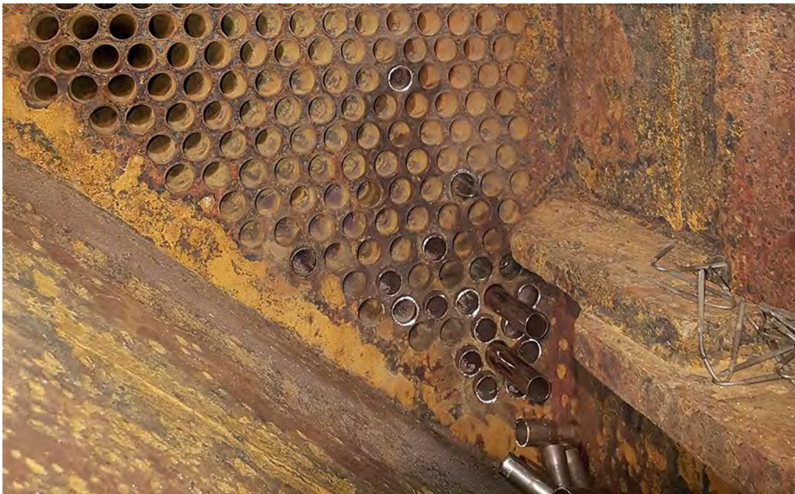
5. Подрезка и торцовка выступающих кромок трубных вставок после гидравлического расширения
