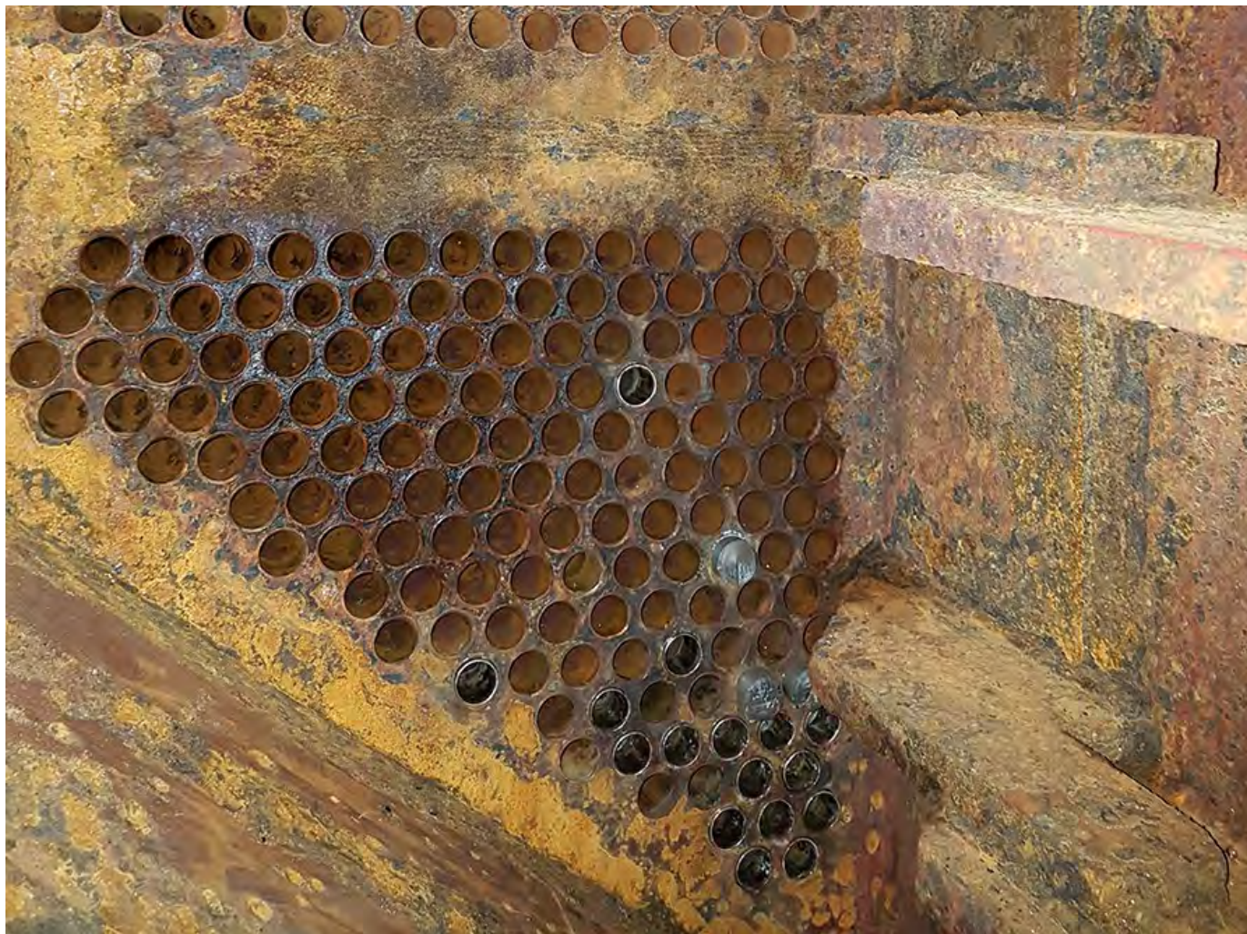
7. Трубная доска после выполнения работ на одном ходу второй секции
