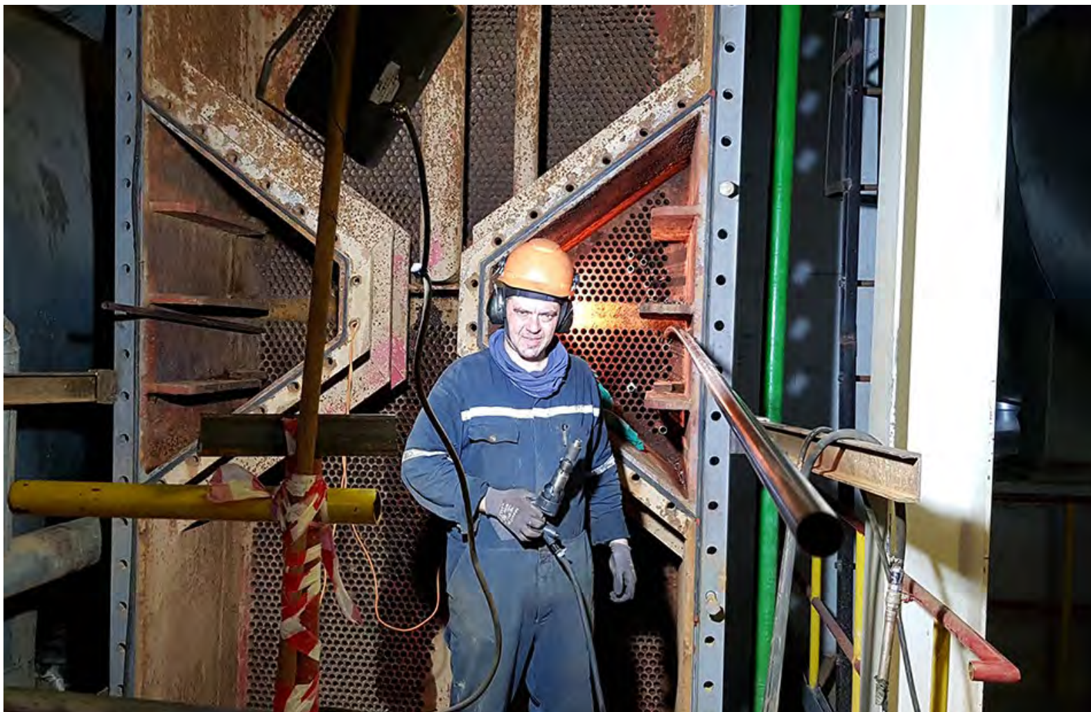
4. Процесс установки вставок внутрь родных трубок
