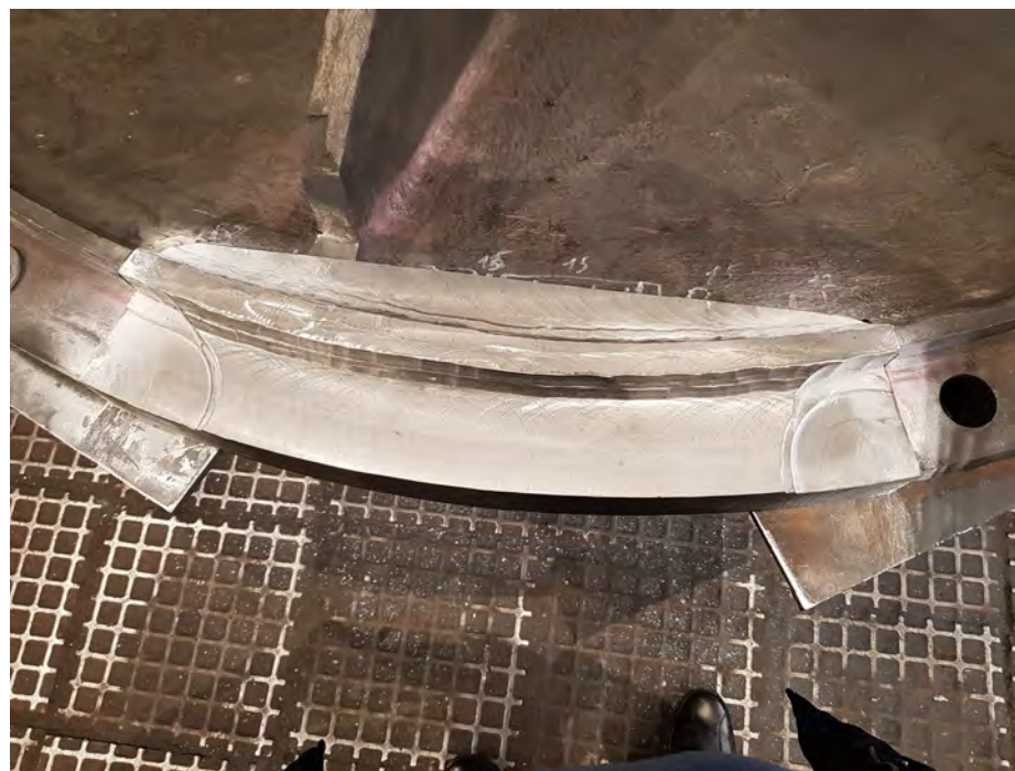
Подгонка ремонтной вставки
