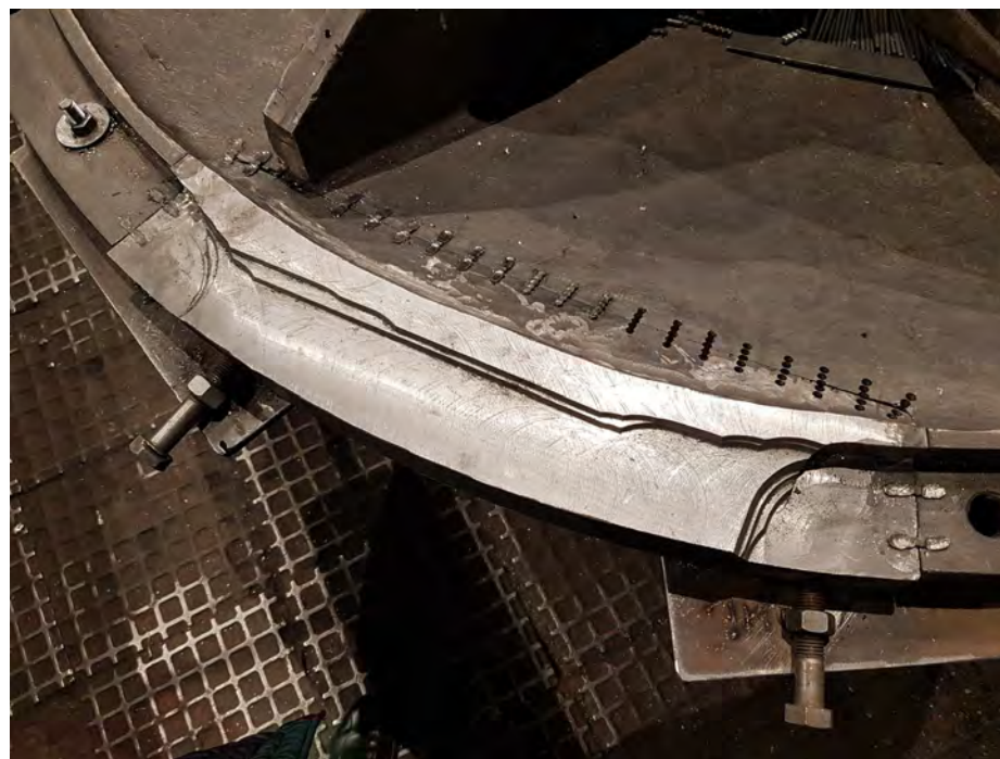
Установка ремонтной вставки
