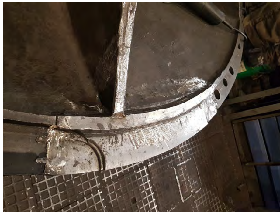
Предчистовая обработка ремонтной вставки
