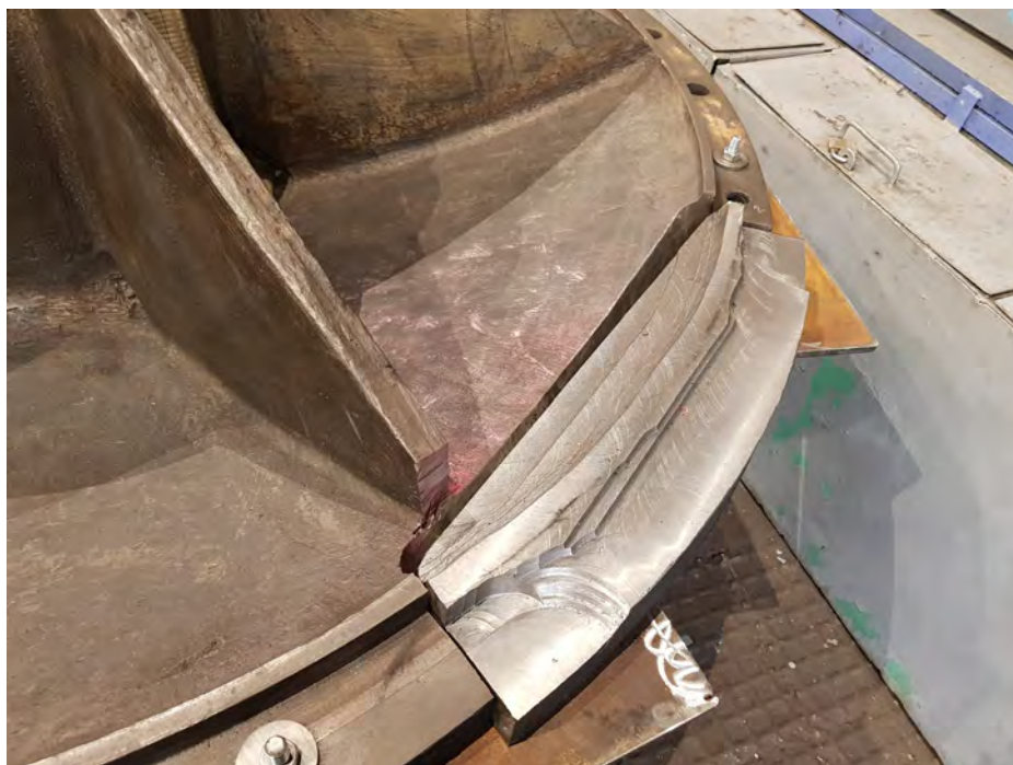
Подгонка ремонтной вставки
