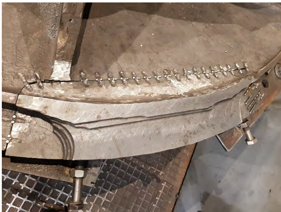
Установка ремонтной вставки
