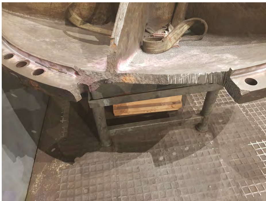
Обработка вылома под ремонтную вставку
