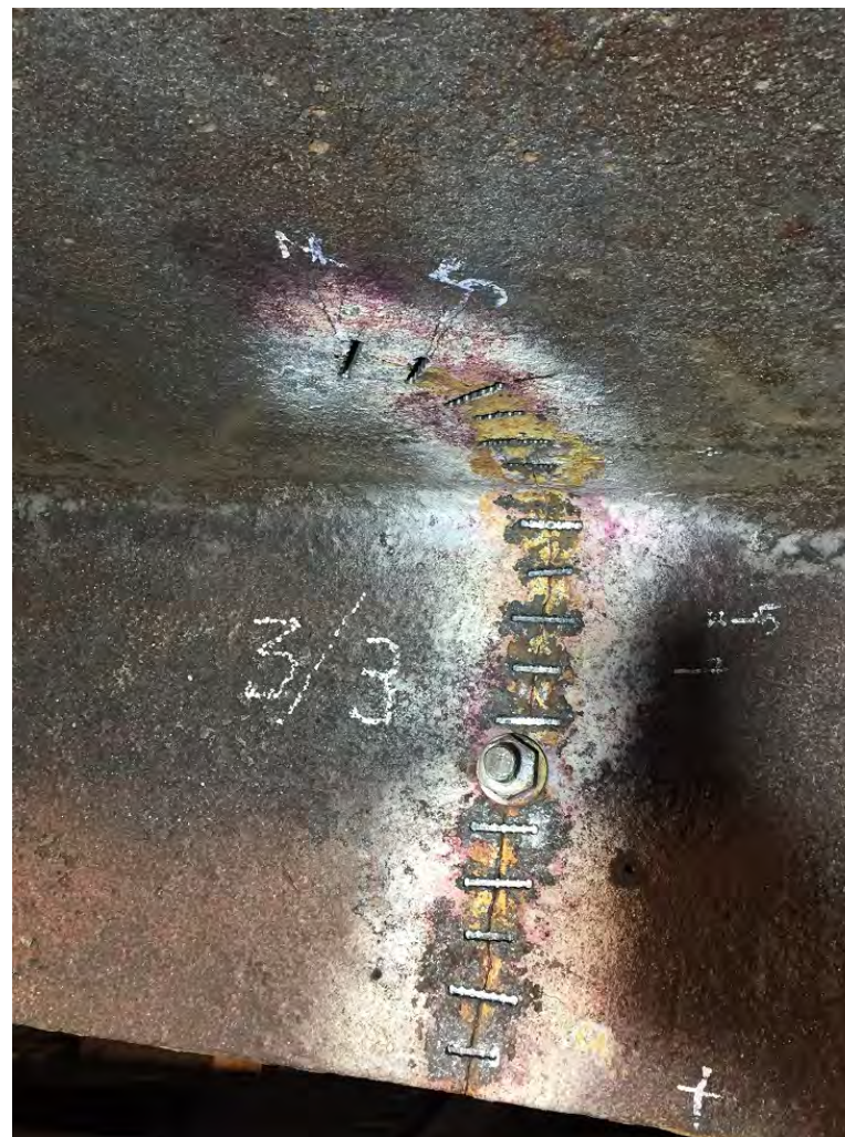
Ремонт трещины по технологии Metalock. Установка ключей-стяжек
