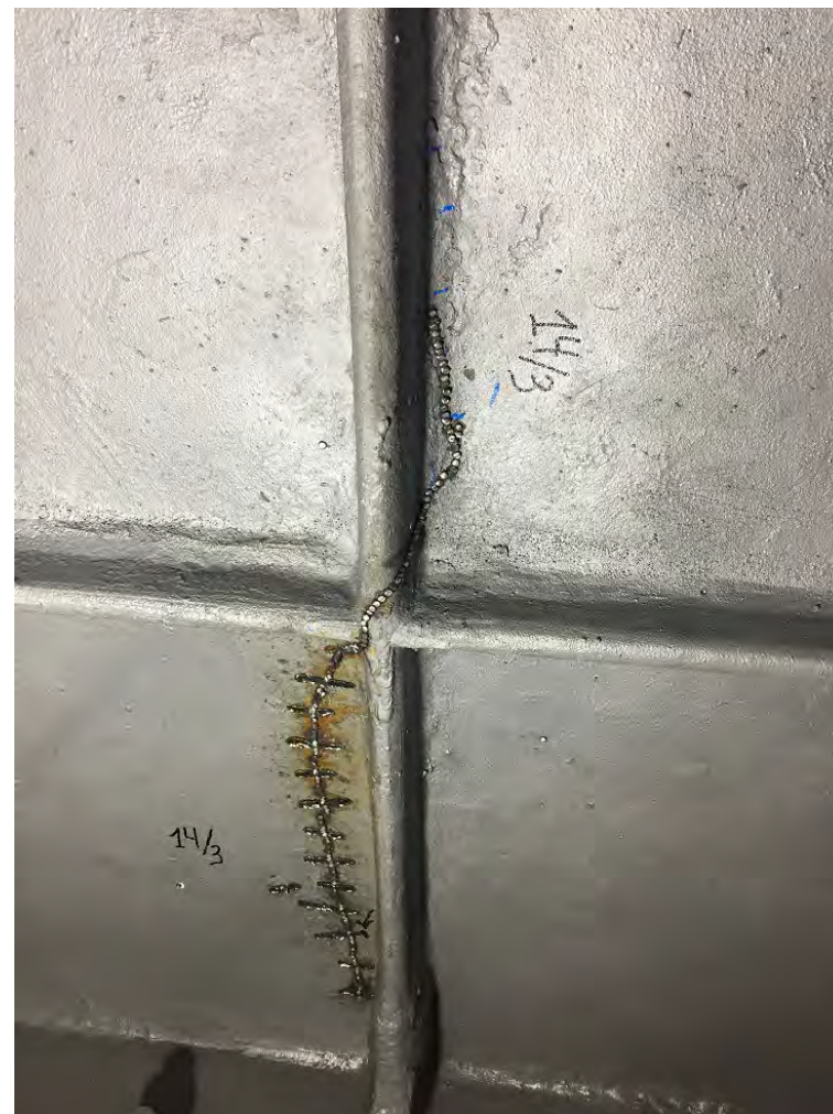
Ремонт трещины по технологии Metalock. Установка ключей-стяжек и герметизирующих шпилек в тело трещины
