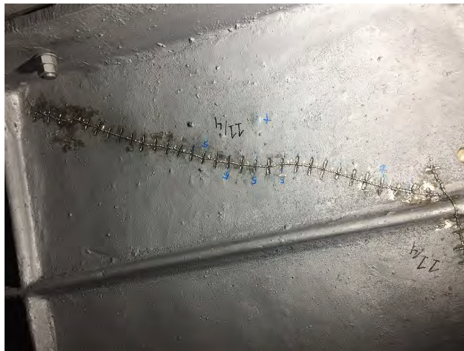
Ремонт трещины по технологии Metalock. Длина зашивки 1700 мм
