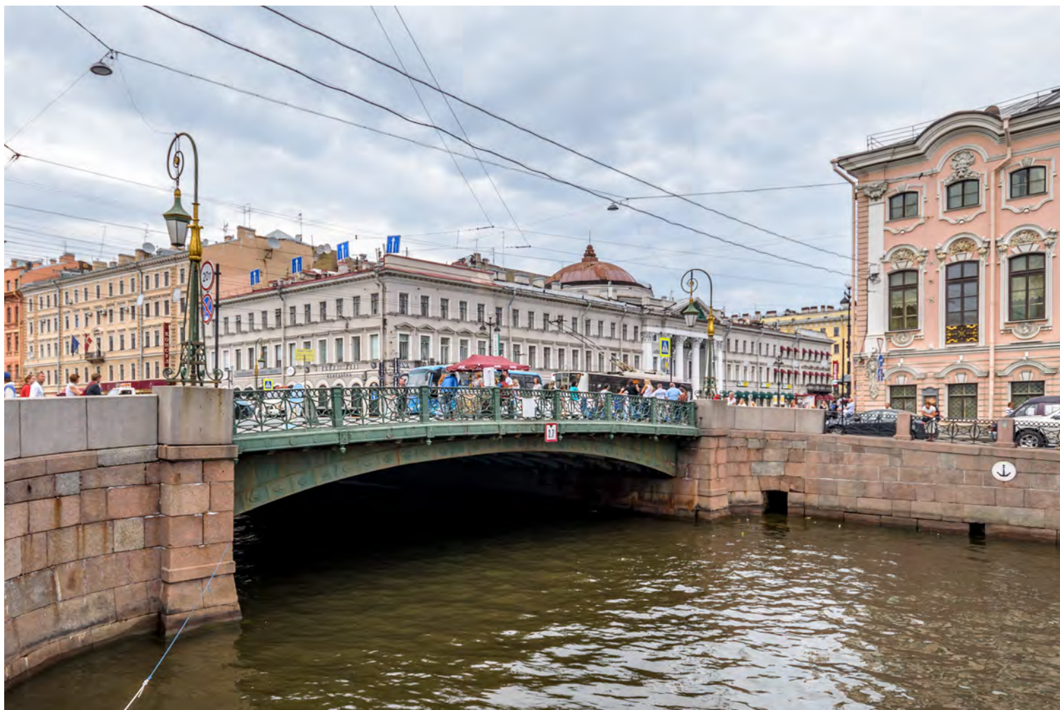
Общий вид моста
