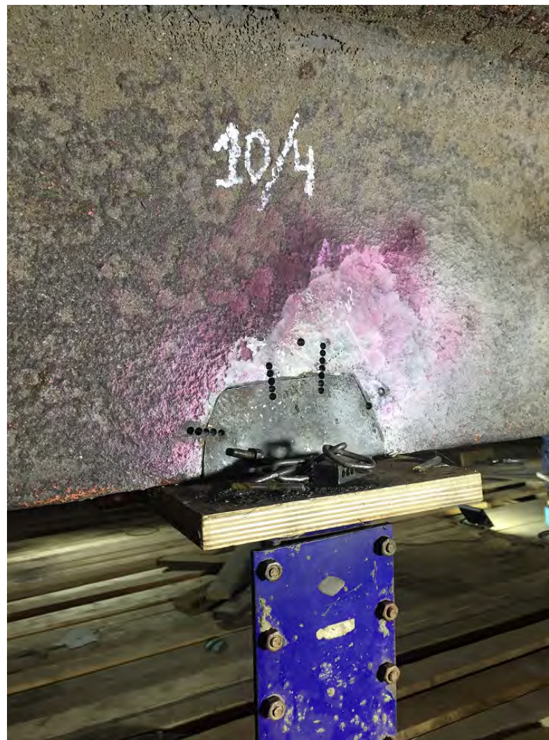
Установка ремонтной вставки на место отсутствующего фрагмента тюбинга
