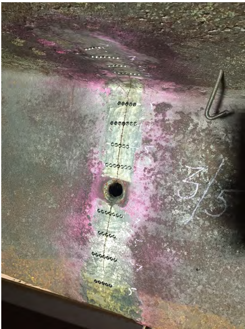
Высверливание отверстий под установку ключей-стяжек
