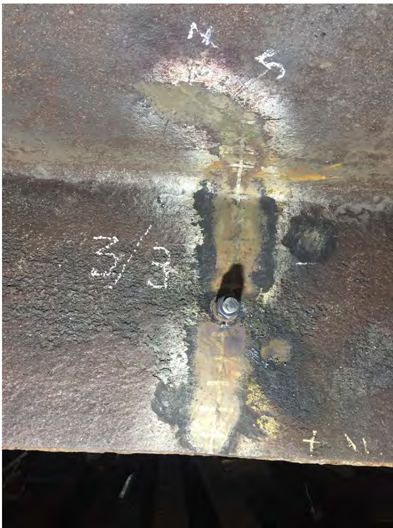
Отремонтированный участок мостового тюбинга
