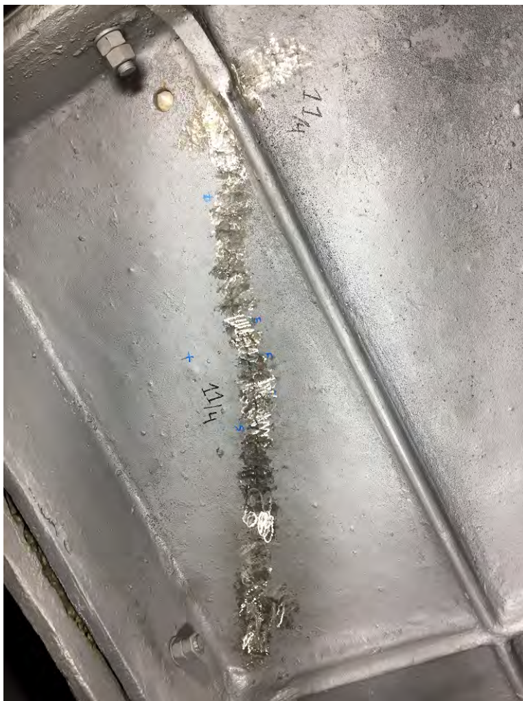
Отремонтированный участок мостового тюбинга, длиной 1700 мм
