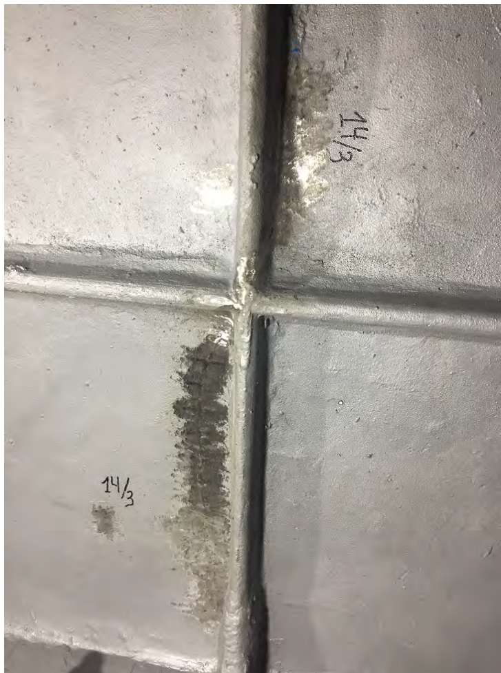
Отремонтированный участок мостового тюбинга
