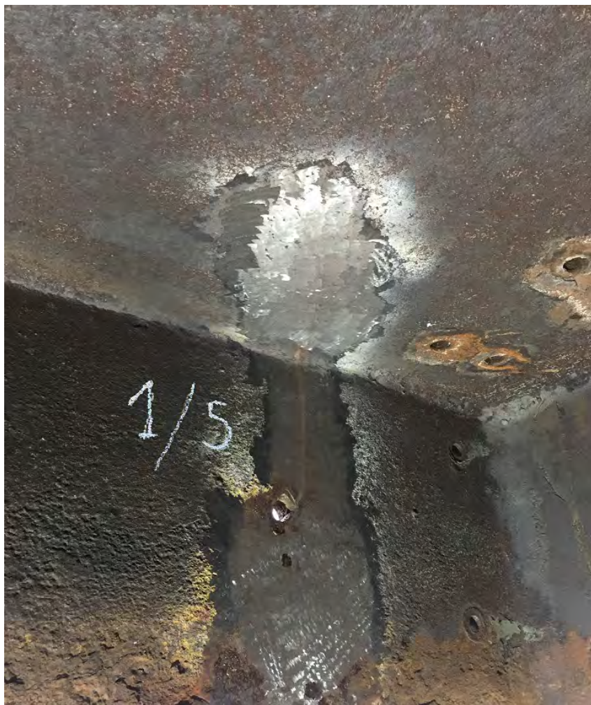
Отремонтированный участок мостового тюбинга
